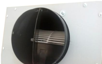
Установка обратного клапана предотвращает вход ветра и выход воздуха.
