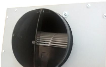
La instalación de la válvula de retención no impide la entrada de viento y el retorno de aire.
