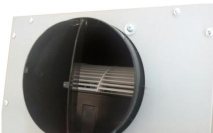
Eine Rückstauklappe sorgt dafür, dass kein ungewollter Luftaustausch zwischen Raum- und Außenluft stattfindet..
