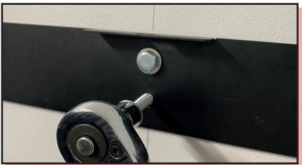
7. Utiliser un tournevis cruciforme pour la vis située au-dessus du support pour le fixer.
