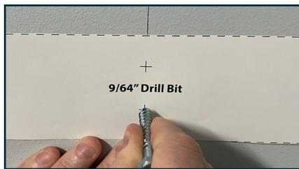
2. Marquer les six trous. À l'aide d'une mèche de 0,3 cm (1/8"), faites dériver les deux trous pilotes pour les vis à bois. À l'aide d'une mèche de 0,6 cm (5/8"), percer les trous pour les boulons à bascule.
