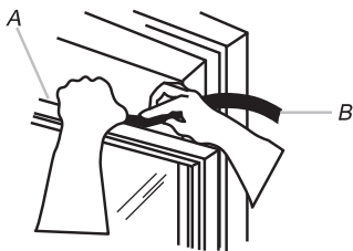
A. Oberseite des unteren Fensterflügels B. Schaumstoffdichtung
